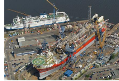
LNG/ FPSO/ Shipping
